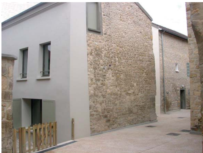
Vue sur le bâtiment B : les enduits ne s'arrêtent pas aux angles mais se retournent sur la face adjacente.
