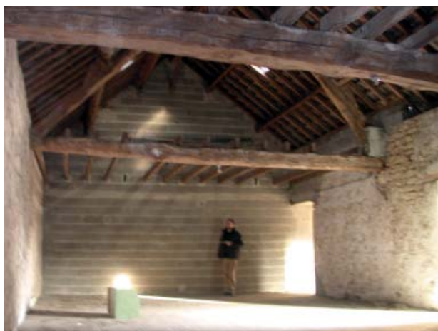
Vue sur les charpentes avant les travaux.
