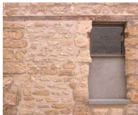
Trace d'une fenêtre rebouchée et d'un percement.
