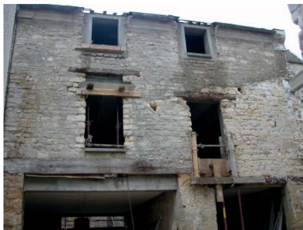
Vue sur la façade principale avec les poutres d'origine conservées et les nouveaux cadres en béton délimitant les percements.
