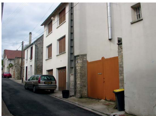
Vue sur les bâtiments d'origine sur rue.
