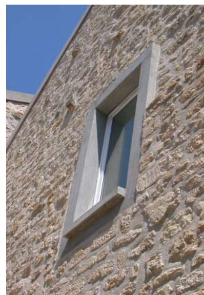
Détail d'un encadrement de fenêtre.
